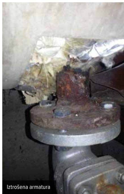
Popravilo segmenta vročevodnega omrežja
