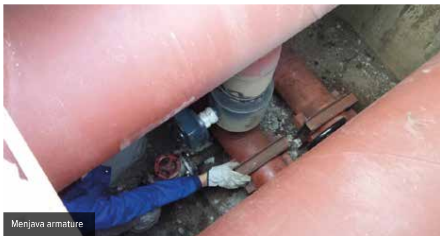
Popravilo segmenta vročevodnega omrežja
